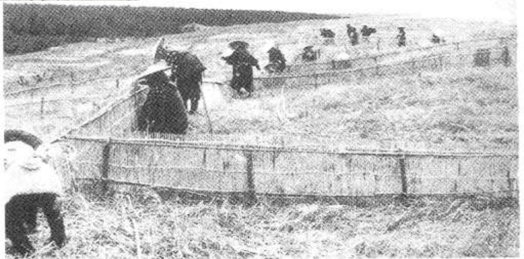
静砂垣・北蒲原郡紫雲寺町大字藤塚浜地内（昭和33年） （『海岸砂地造林事業の実績とその経過』）
